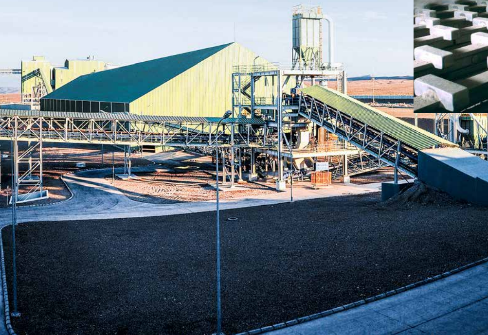
Bild 2: Das Polytrack-Fördersystem kühlt und transportiert den Zementklinker.
