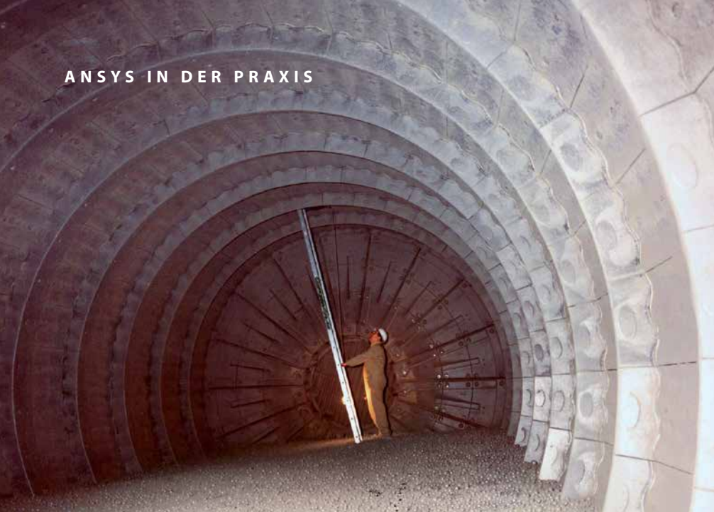
Bild 3: Die Vermahlung des Zements erfolgt mithilfe von Kugeln in Rohrmühlen.
